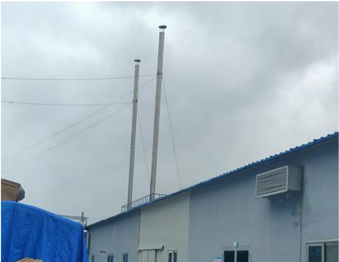
锅炉废气排气筒
