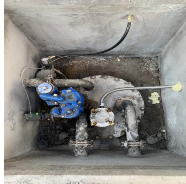
图 4-1 检测口及油气回收管线
