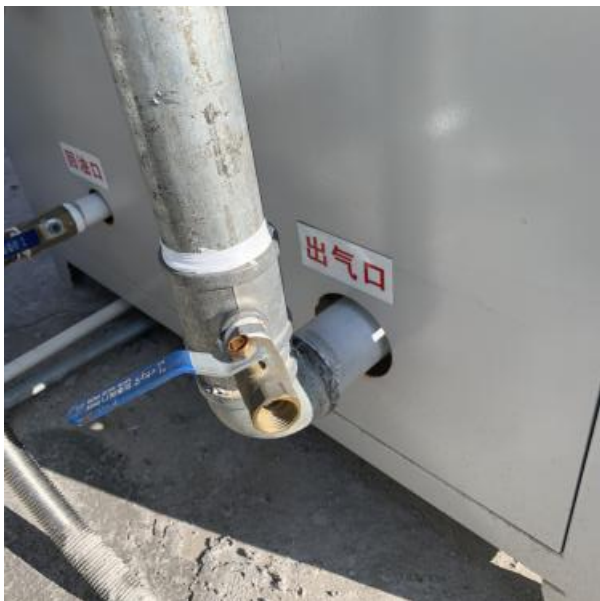
图 4-1 检测口及油气回收管线
